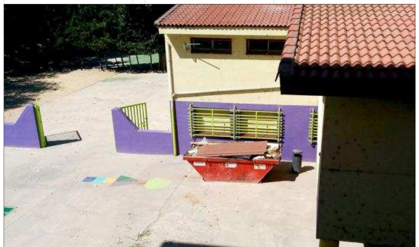
Contenedor de obras en el interior del colegio Juan de Yepes.
